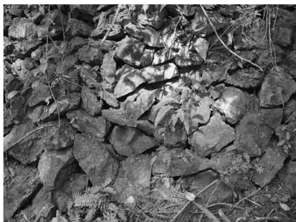
第8図 山側から切り出した母岩を積んだ石積み(大久保)
